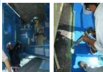
MEによる点検・補修作業の実証 (漏水対策を実施)
