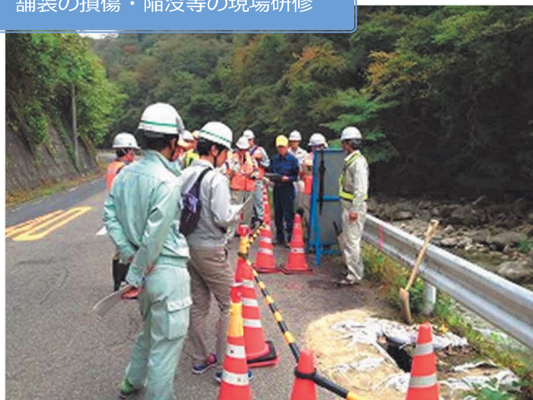
舗装の損傷・陥没等の現場研修
